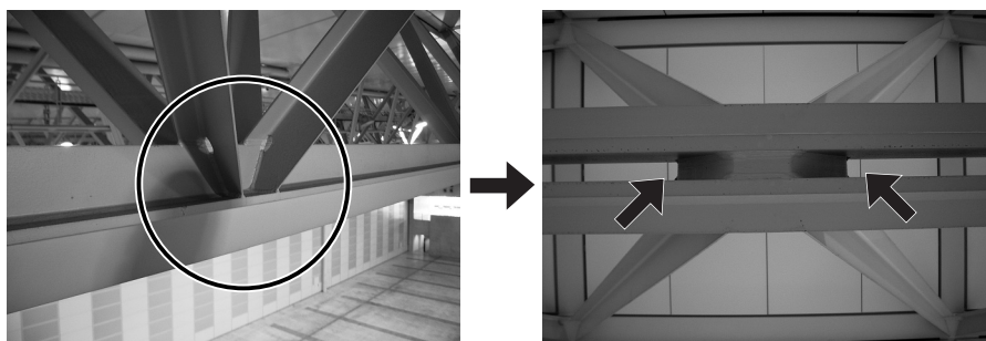
北ホール（9-11ホール）天井躯体と吊物用プレート写真
